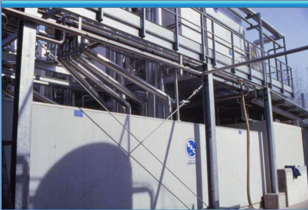
LATTERIA DEL MONTELLO Giavera del Montello, Italy (5) TSU-700C 11,8 MWh
