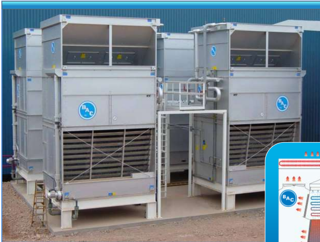
P & R INSULATION LTD. (Cold store), Birmingham, U.K. (4) HXI-540 3,3 MW
