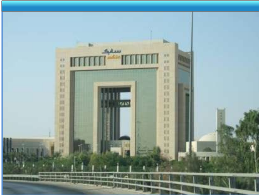
SABIC HQ – Riyadh (KSA) (45 MWh) – (15) TSU-761M
