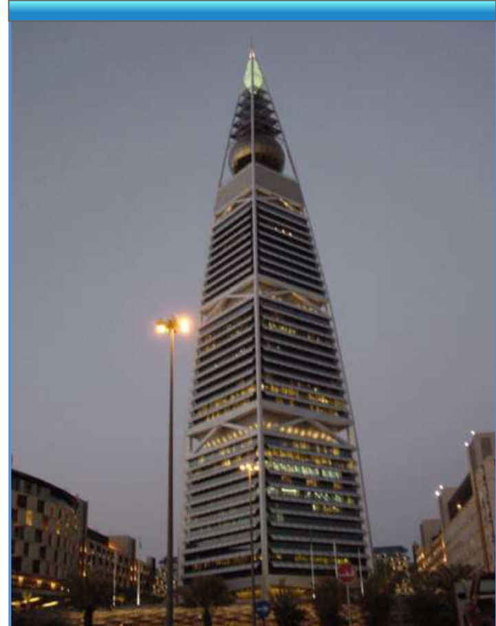
AL FAISALIAH – Riyadh (KSA) (30 MWh) – (11) TSU-761M
